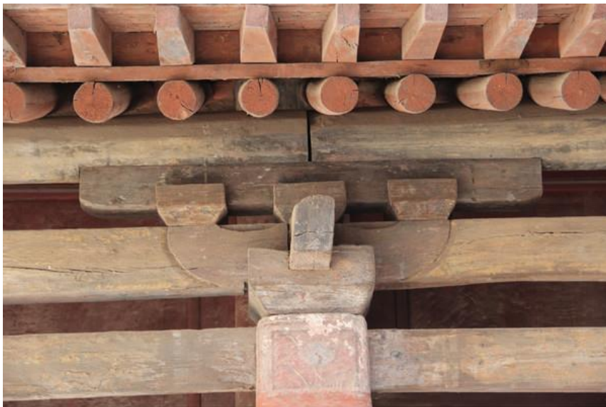
山西晋城西溪二仙庙东梳妆楼一楼廊柱斗栱（金）
