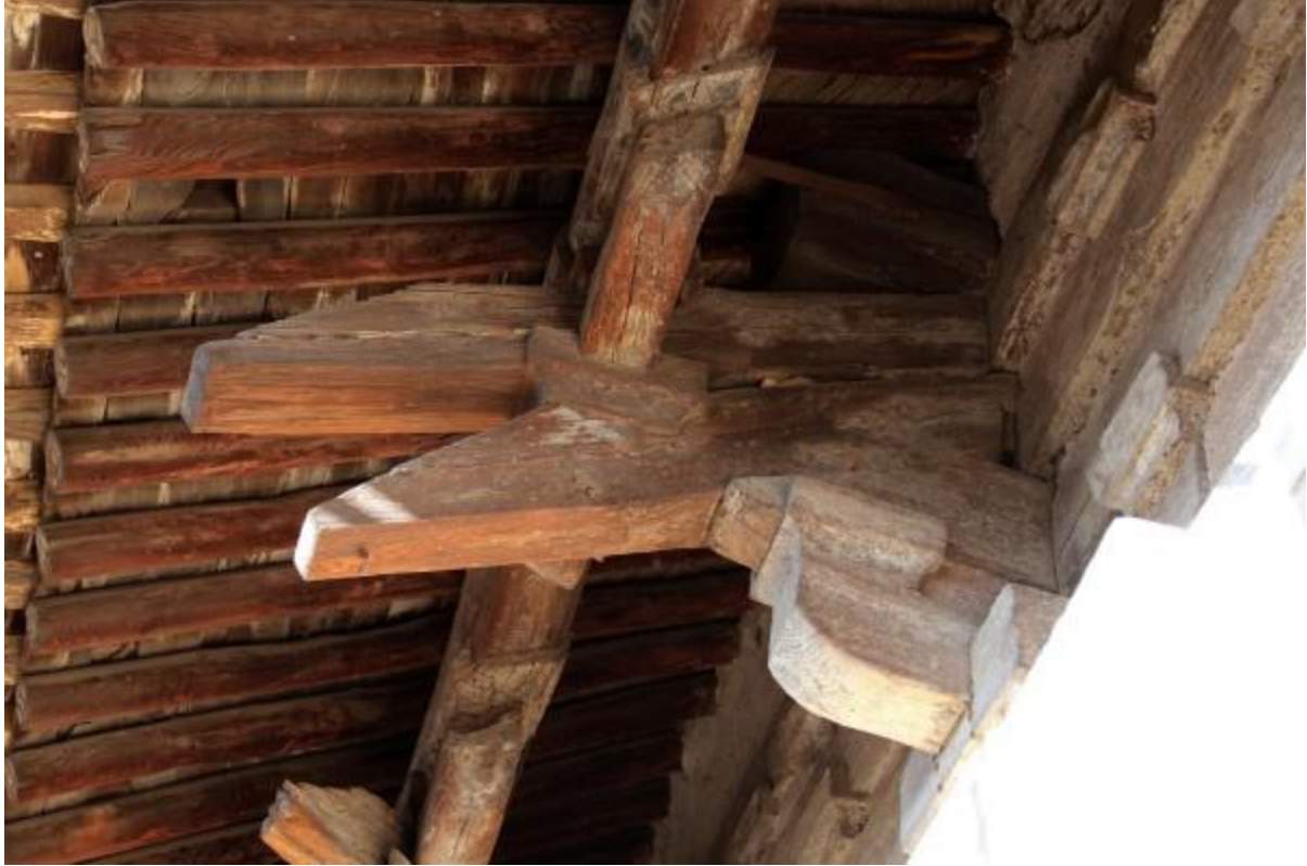
山西晋城青莲寺上寺正殿（宋）补间铺作
