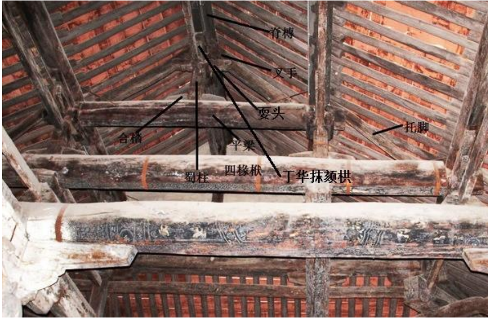
山西陵川礼义镇南吉祥寺前殿（宋）殿内梁架结构
