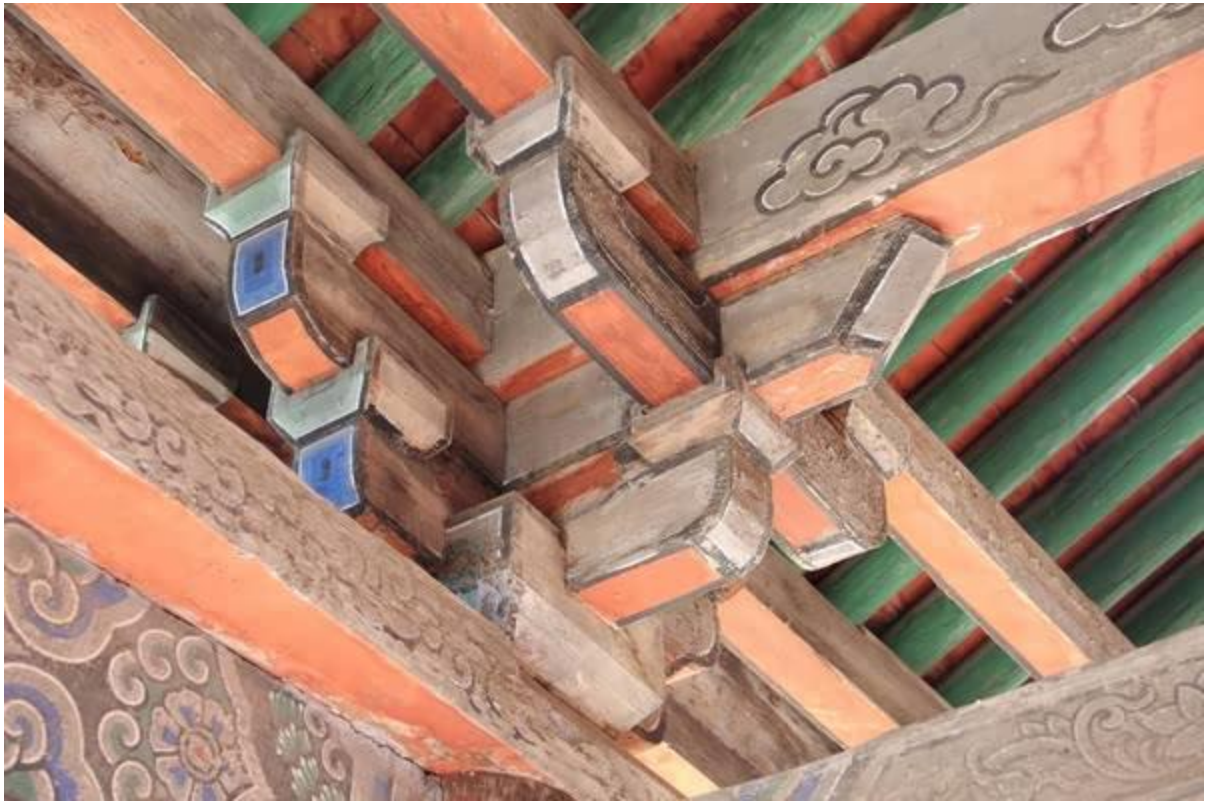
长子法兴寺碑廊 单翘三踩斗拱
