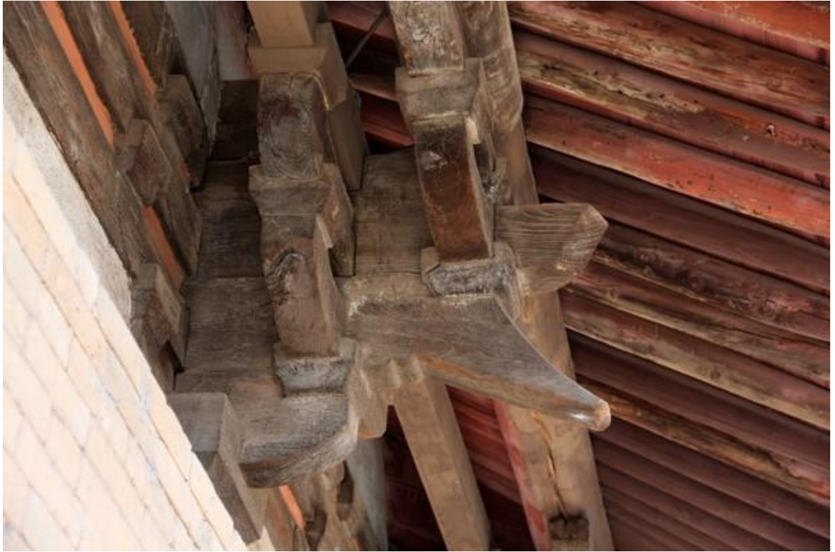
山西陵川龙岩寺过殿补间斗栱（金代）
