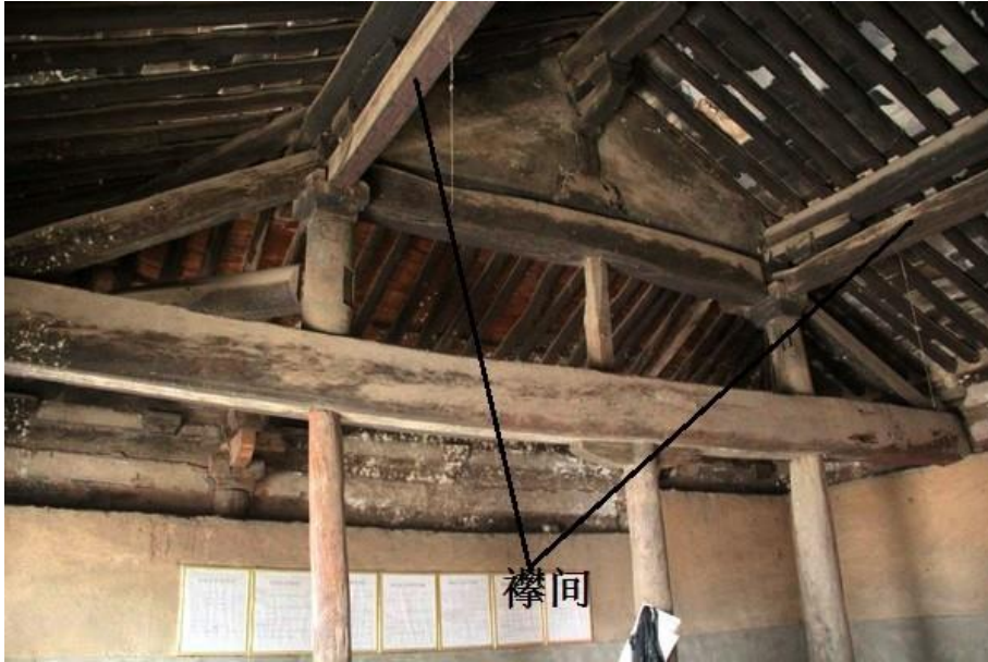
山西平顺王曲天台庵大殿（唐）殿内梁架结构
