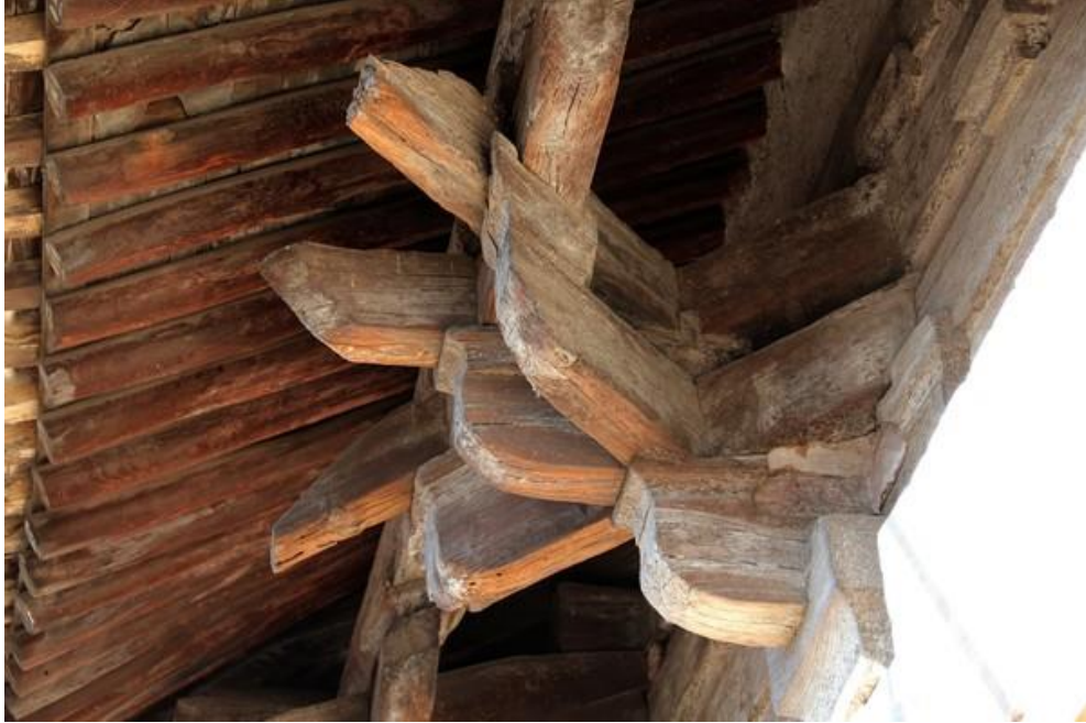
山西陵川礼义镇南吉祥寺中殿（北宋）当心间补间斗栱 外檐斜栱
