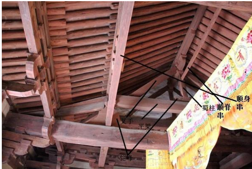
山西平顺大云院弥陀殿（五代）梁架结构
