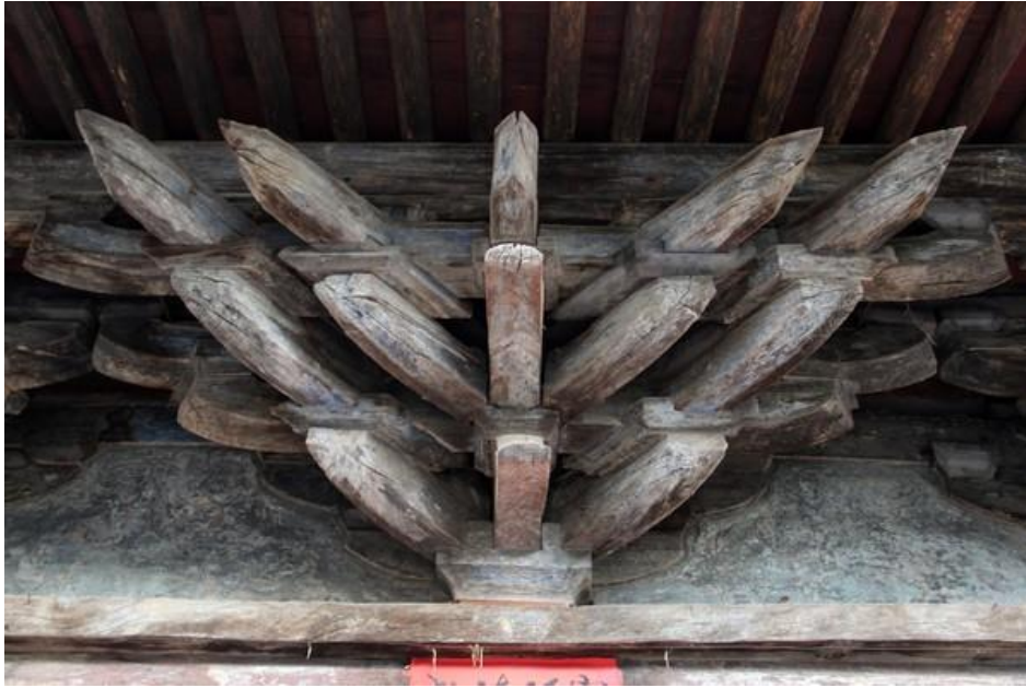
山西平顺龙门寺天王殿外檐明间补间斗拱（金）
